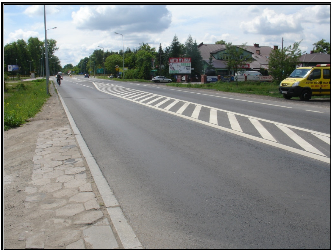
Fot. 6 Kierunek Warszawa
