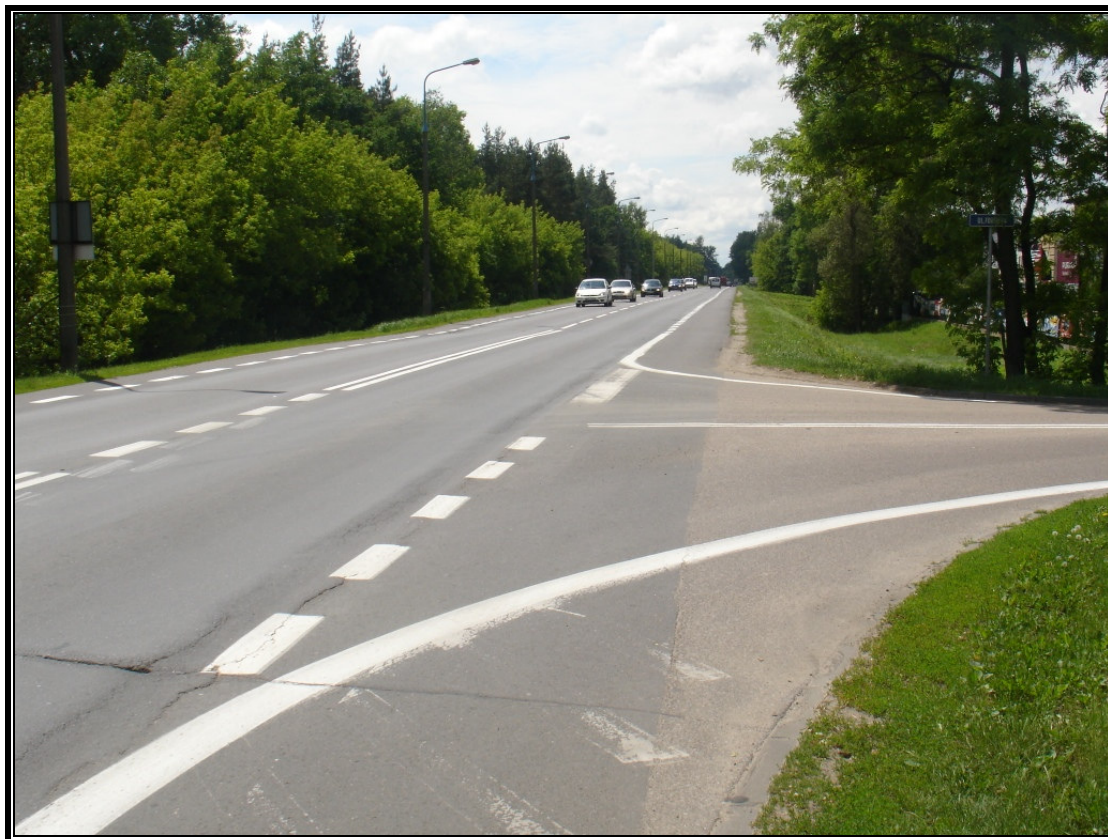
Fot. 4 Kierunek Warszawa
