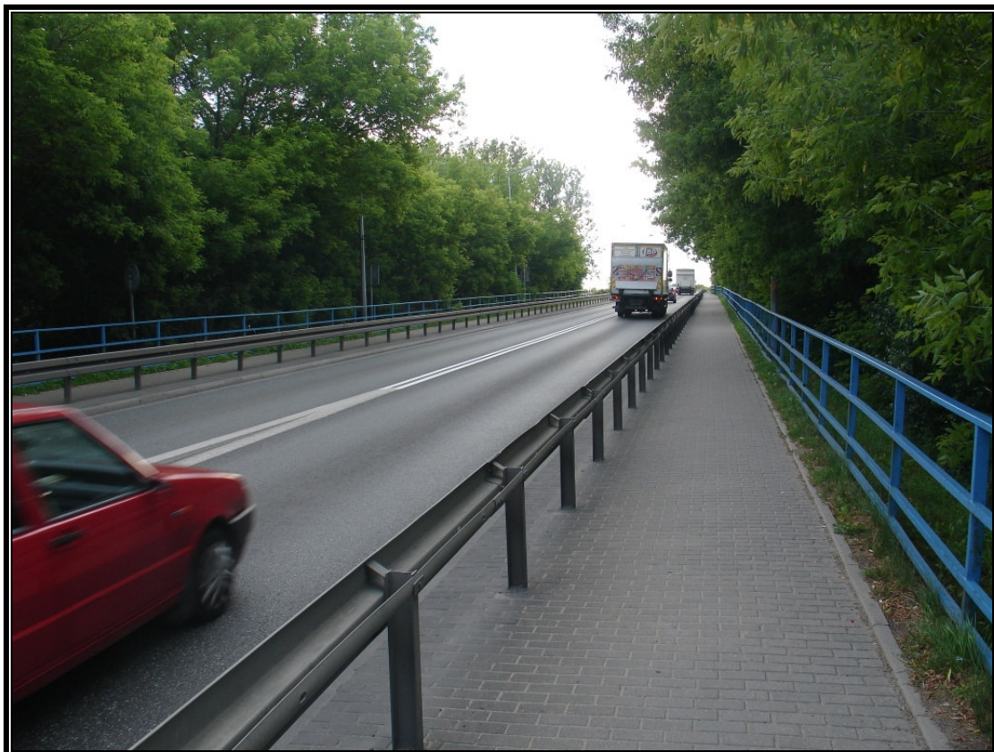
Fot. 2 Kierunek Warszawa
